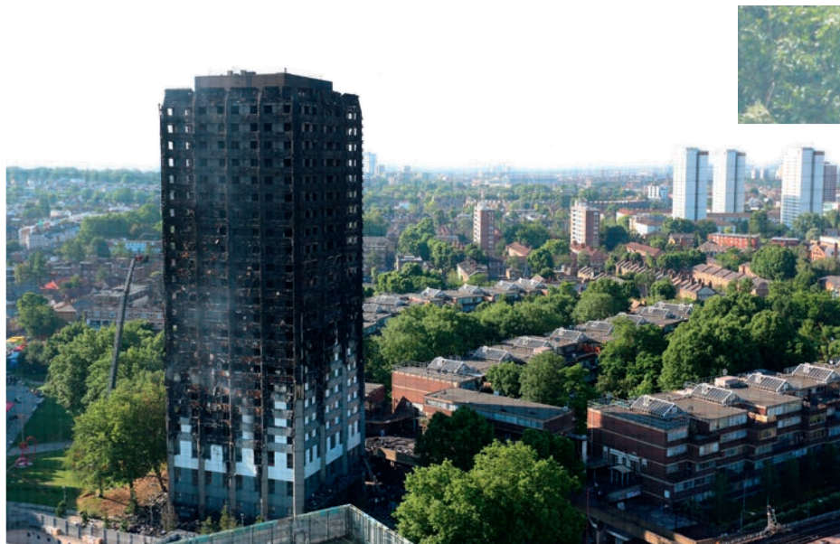
Der Grenfell Tower, ein Sozialbau im Westen Londons, brannte am 14. Juni 2017 völlig aus. Dabei kamen 71 Menschen ums Leben, 223 Personen konnten sich retten. Vor der Katastrophe hatte es immer wieder Beschwerden über Mängel bei Brandschutz gegeben.
