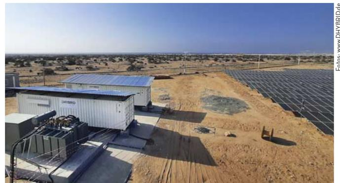
oben: „DHYBRID“-Batteriespeicher im klimatisierten Container; rechts: Das Lithium-Ionen-Stromspeicher-System verfügt über eine Kapazität von zwei Megawattstunden; Stromersparung: 12.800.000 kWh pro Jahr; CO<sub>2</sub>-Einsparungen: 8.960.000 Kilogramm pro Jahr.
